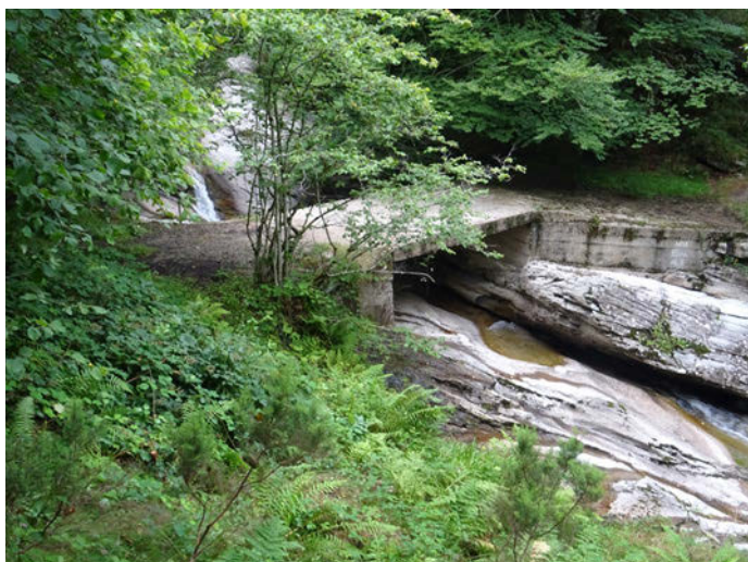
Foto 3: Puente sobre roca madre en el río Saja
