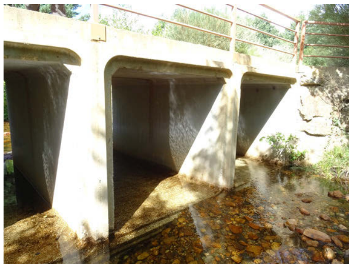
Foto 10: Puente con paramento sobre el lecho del río Negro
