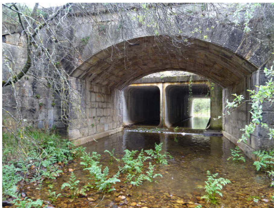
Foto 9: Paso entubado en la zona 2 del Arroyo Rebedul bajo la carretera LE-232
