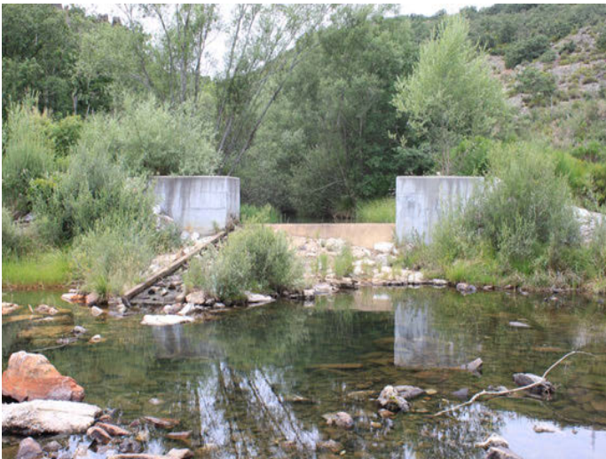
Foto 9: Azud 2 del Arroyo Resoba con la escala de peces no operativa.
