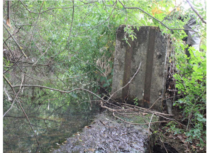
Foto 8: Solera y muro de 1,5 m de altura del Azud 1 que supuestamente se encuentra en desuso.
