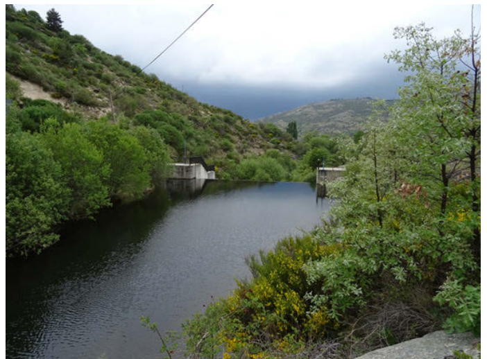
Foto 6: Agua embalsada por la Presa del Calvario.
