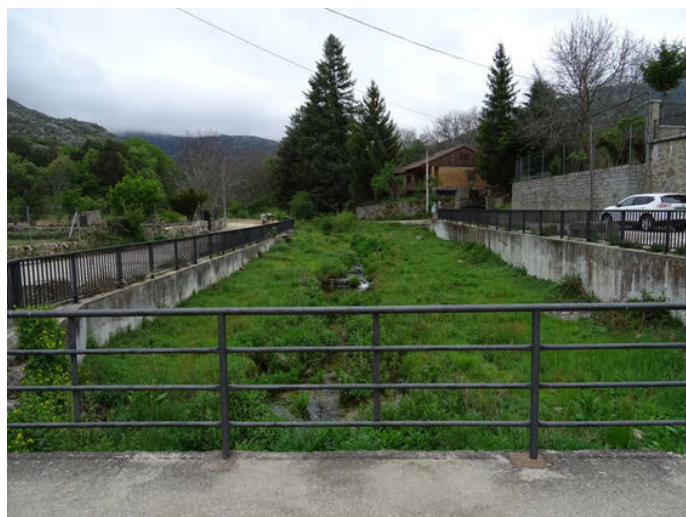
Foto 8: Tramo encauzado del arroyo del Puerto en Navacepedilla de Corneja.
