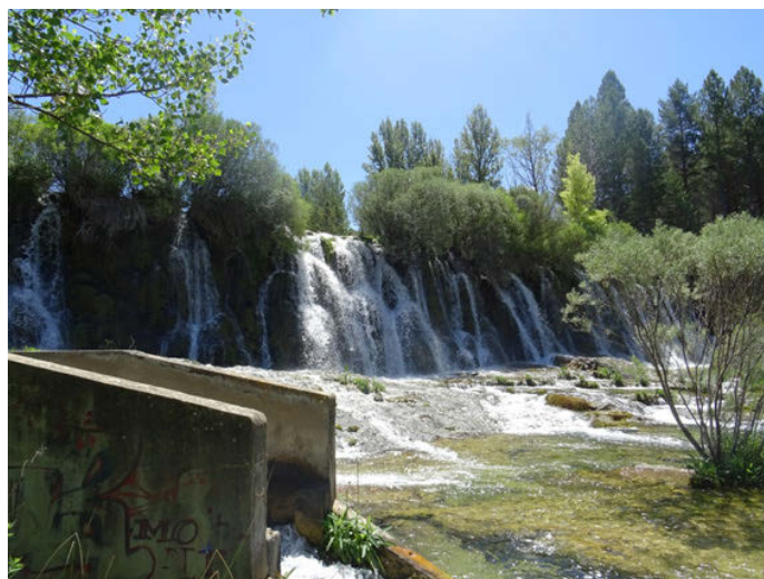
Foto 12. Azud molino de arriba del Peralejos en el cierre de la reserva y su escala de peces
