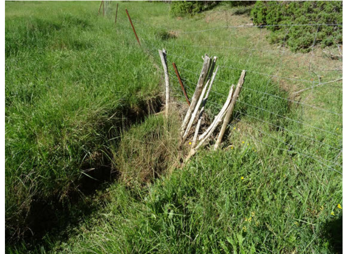
Foto 2: Vallas ocupando el cauce en la zona 1
