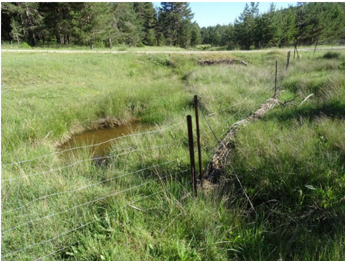
Foto 3: Paso entubado para el paso de la pista y valla en el arroyo,
