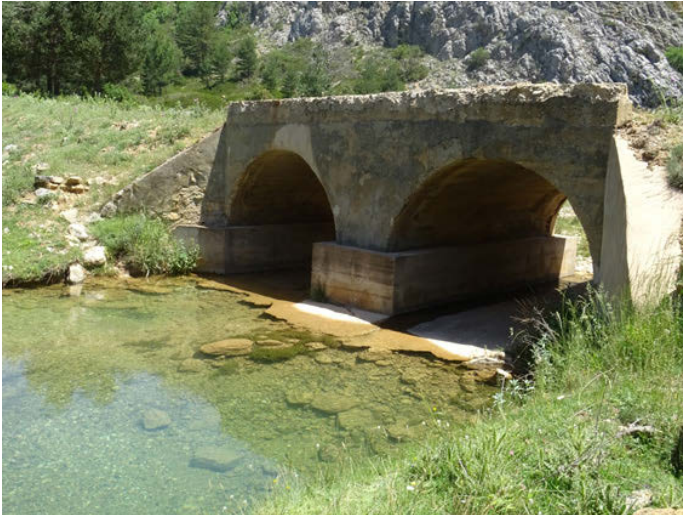
Foto 7: Puente con paramento al inicio de la zona 2
