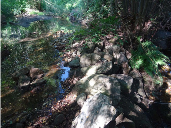
Foto 1. Azud de gran tamaño y colmatado en las inmediaciones del municipio de Navahondilla.
