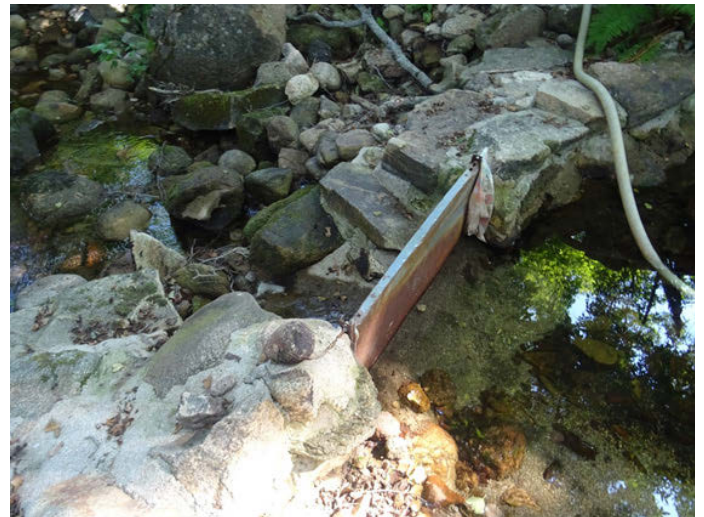
Foto 4. Azud con compuerta de apertura y tubo para la toma de agua
