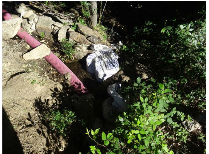
Foto 22. Toma de agua en la parte alta de la reserva aguas abajo del paramento
