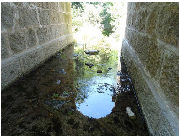
Foto 17. Paramento del puente de la carretera AV-P-420
