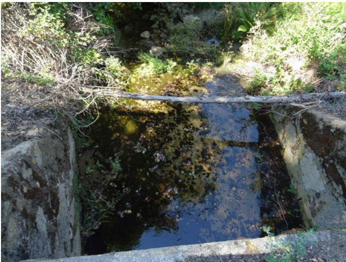
Foto 15. Paramento del puente de la AV-913
