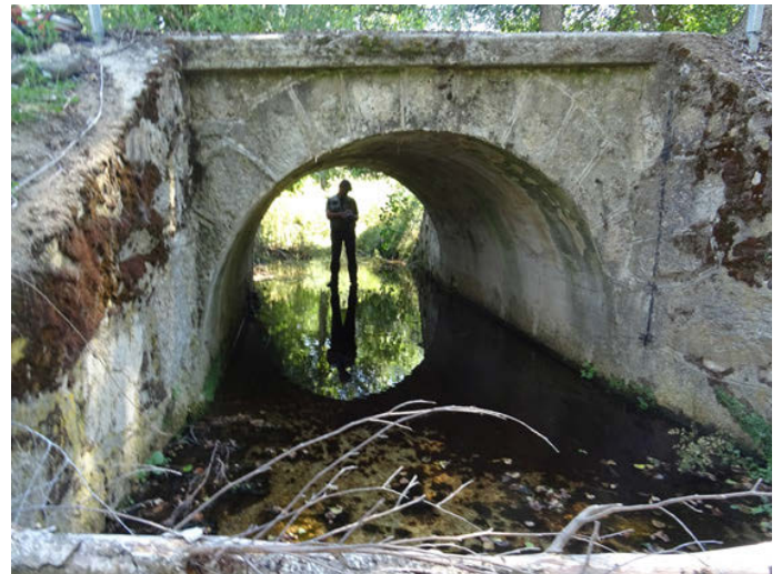
Foto 16. Paramento del puente de la AV-913
