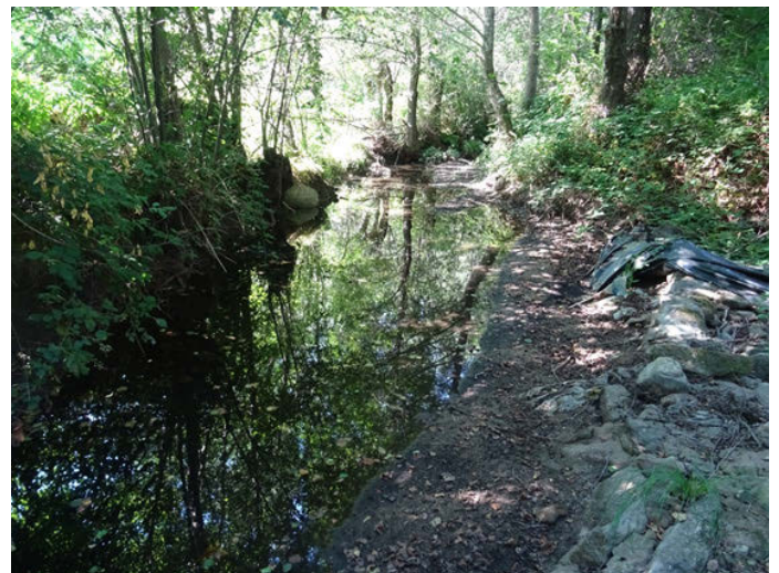
Foto 6. Segundo azud de gran tamaño totalmente colmatado en parte media de la zona 3
