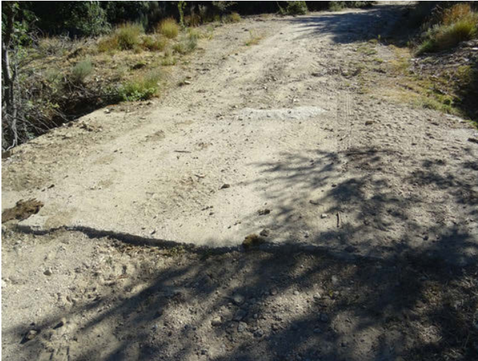
Foto 19. Paso entubado en la parte alta de la reserva, en la zona 2
