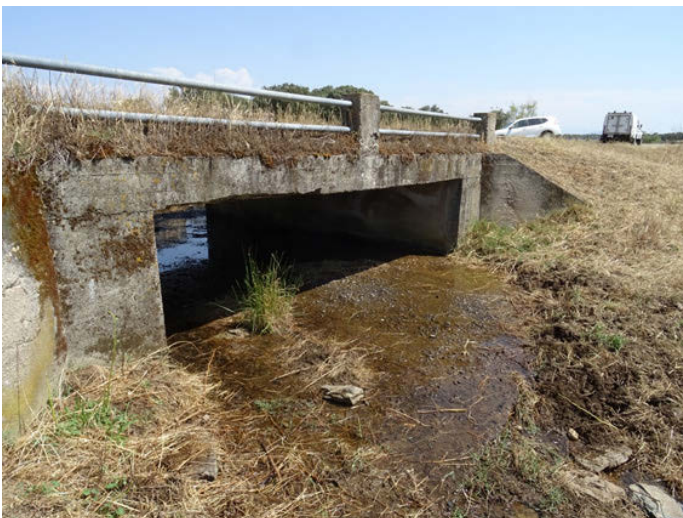
Foto 5. Puente en el tramo 1 de la RNF del Río Barbaón
