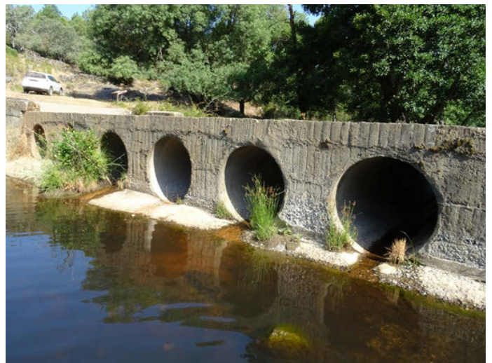
Foto 6. Paso de vehículos en el tramo 2 de la RNF del Río Barbaón.
