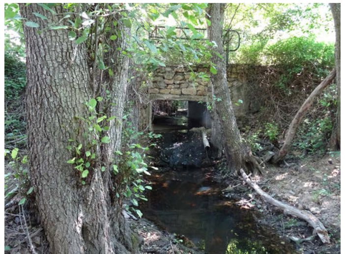
Foto 6: Puente con paso sobre paramento en la zona 2.
