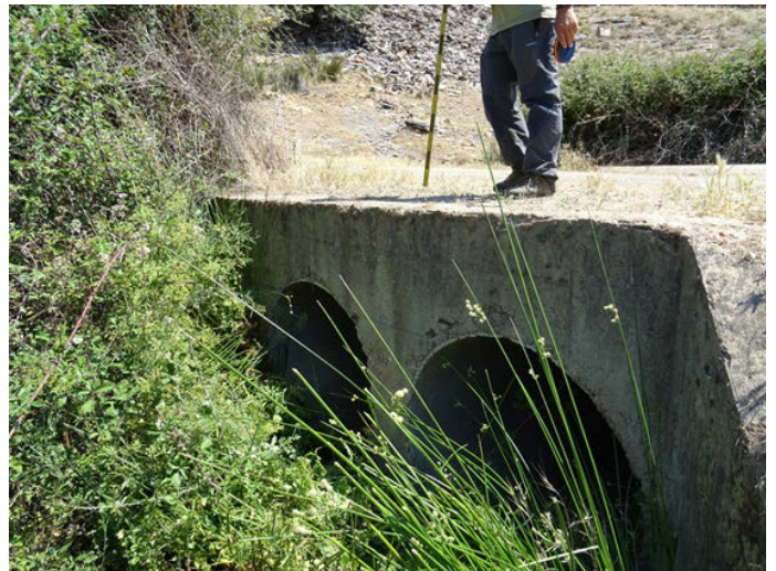
Foto 4: Paso entubado en la zona 2.
