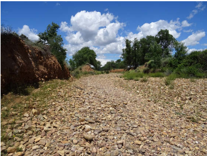
Foto 15. Tramo con motas laterales de protección frente a inundaciones.
