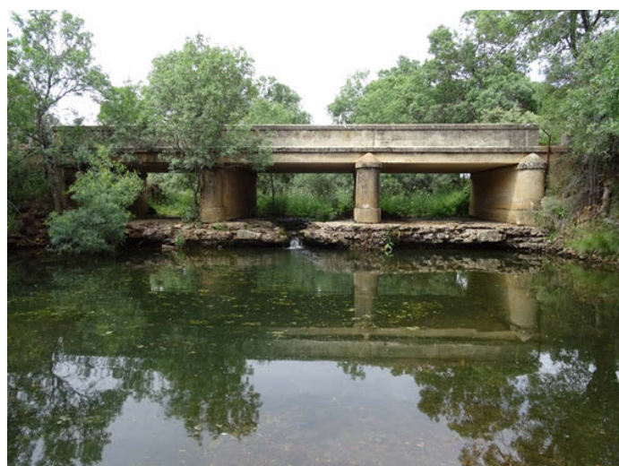
Foto 11. Puente antiguo del Molinillo, su base queda por encima del nivel de agua (Mayo 2007)
