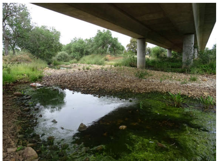
Foto 12. Puente nuevo de la carretera CM-4017 de Retuerta de Bullaque -El Molinillo
