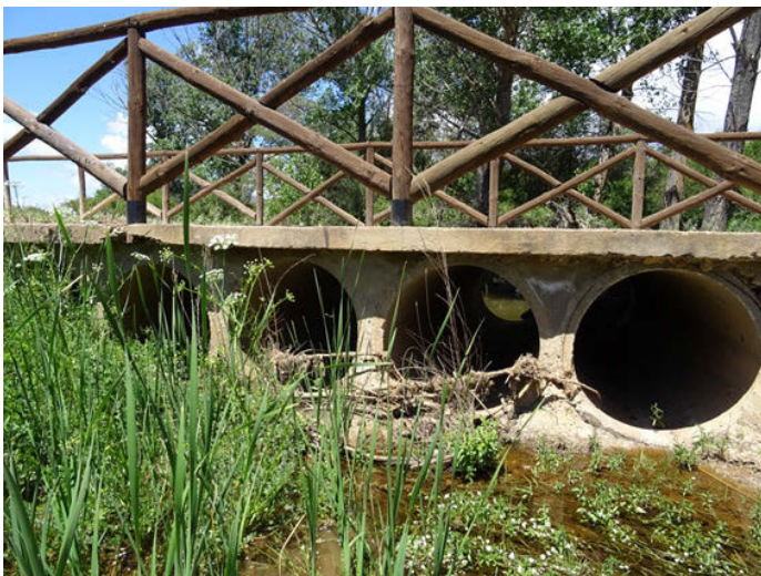
Foto 3: y 4: Puente de la finca de Las Gamas, en el tramo alto de la reserva. En mayo de 2017 los tubos de paso quedaban totalmente en seco
