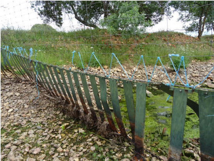
Foto 13. Vallado cinegético transversal situado aguas abajo del puente nuevo de la carretera
