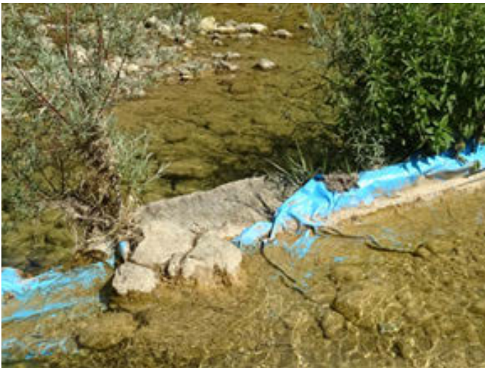
Foto 8. Azud construido con piedras y plásticos en la RNF del Río Tus
