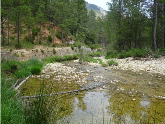
Foto 6. Obra longitudinal de estabilización de la pista forestal en la cabecera del río Tus
