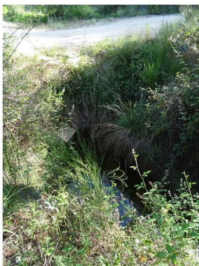
Foto 5. Obstáculo del tipo paso entubado localizado en cabecera de la RNF para un cruce de camino que está descalzado, provocando una desconexión con el cauce.
