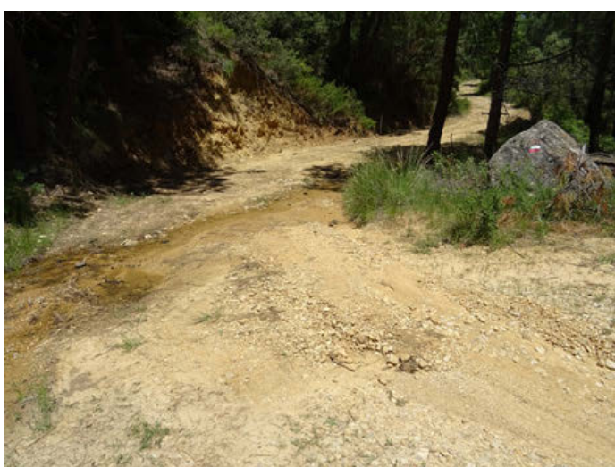
Foto 5. Cruce de camino que se convierte en un obstáculo infranqueable en la zona cercana a la aldea de La Parrilla (Yeste).
