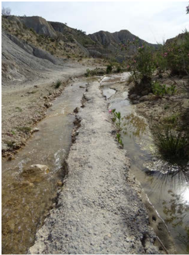
Foto 19. Conducción hormigonada por el propio cauce de la RNF del Río Chícamo
