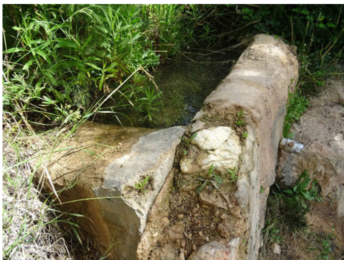
Foto 8. Captación directa mediante un grifo en el cauce del Río Chícamo tras su nacimiento
