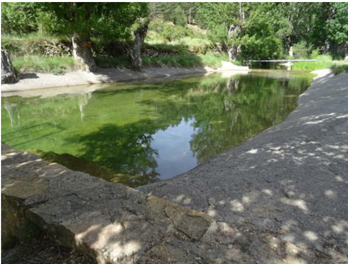
Foto 9. Impermeabilización de lecho con hormigón en el Azud de compuerta de piedras, con código 661 Inventario azudes CHJ.
