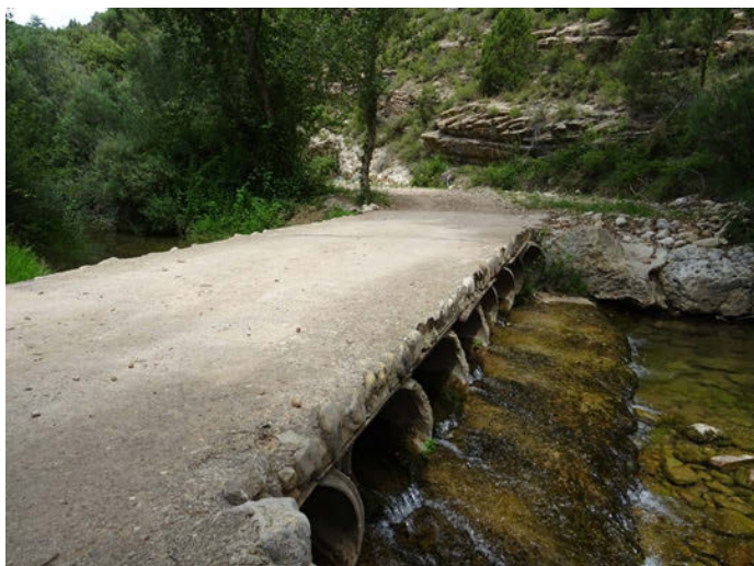
Foto 25. Paso entubado de 8 tubos para acceso al Mas de Desmador.
