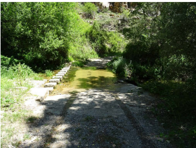
Foto 23. Vado de hormigón para cruce de camino-cauce aguas arriba del puente de la carretera A-1701.
