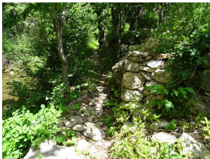
Foto 16. Gaviones para protección de cultivos que se utiliza en senda fluvial río Linares en la ribera de Linares de Mora.
