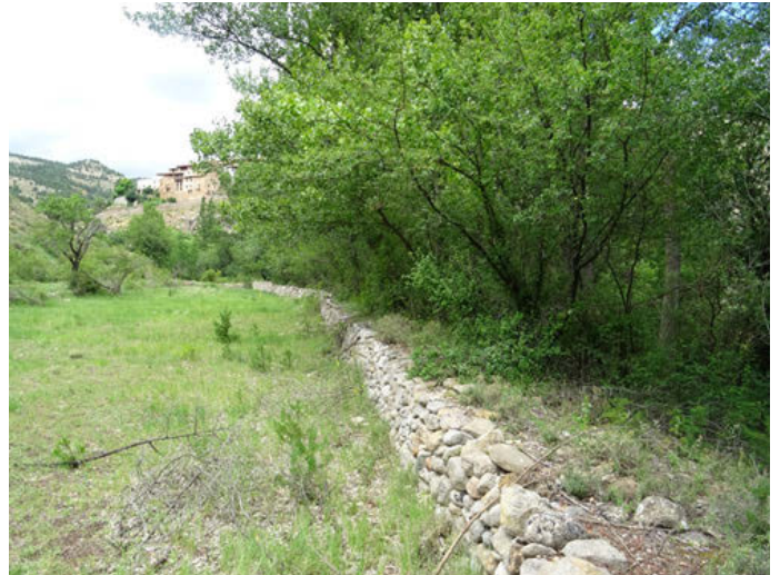
Foto 20. Muro de piedras en margen derecho del río ribera de Linares de Mora.
