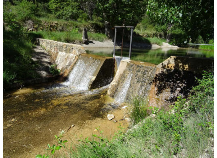
Foto 8. Azud de compuerta de piedras, con código 661 Inventario azudes CHJ, en la ermita de Loreto de Linares de Mora.
