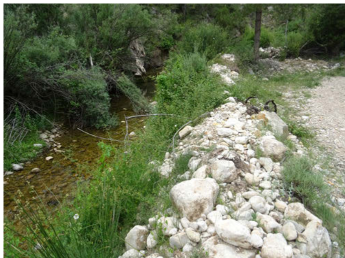
Foto 26. Mota de protección de camino para acceso al Mas de Desmador.
