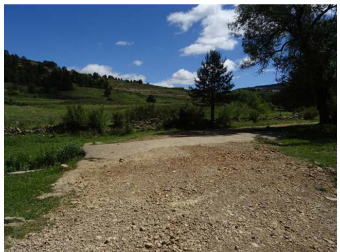
Foto 12. Paso entubado de 2 tubos al inicio de la Zona 2.
