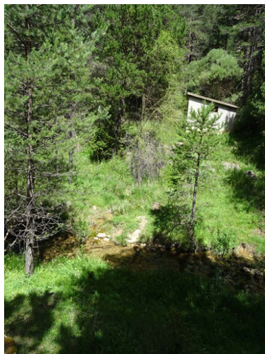
Foto 13. Captación de agua para consumo humano en la zona de los Caños de Gúdar (Zona 2)
