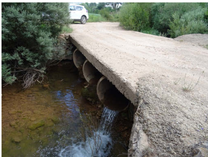
Foto 15. Paso entubado de 3 tubos para un cruce de camino en Zona 3.
