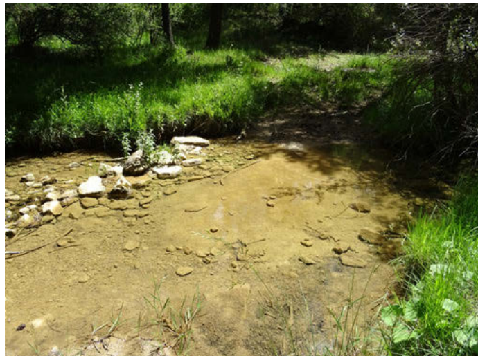
Foto 14. Vado de hormigón para conducción subterránea de agua procedente de los Caños de Gúdar.
