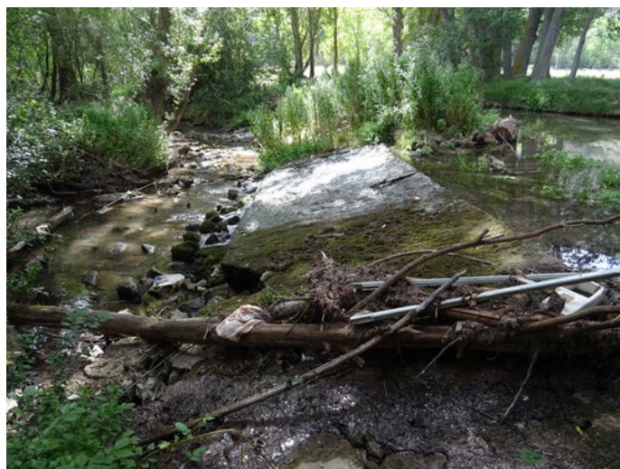
Foto 34. Antiguo azud perteneciente al acueducto romano de Albarracín-Gea-Cella
