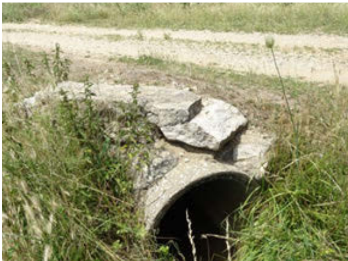
Foto 7. Paso entubado en el tramo de cabecera de la RNF del Río Guadalaviar
