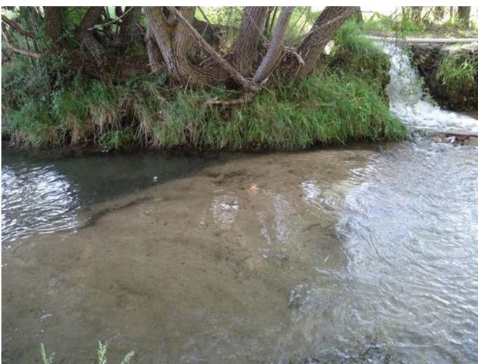
Foto 17. Depósito de sedimentos por el retorno del caudal desde una acequia
