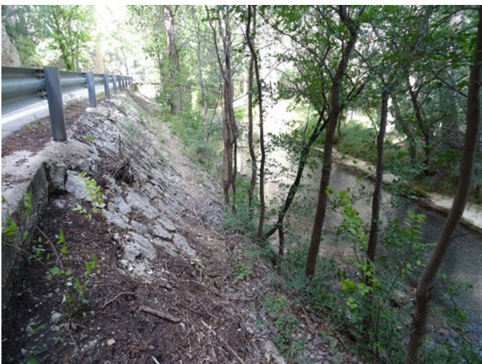
Foto 29. Obras longitudinales de protección de la carretera A-1512 en Albarracín
