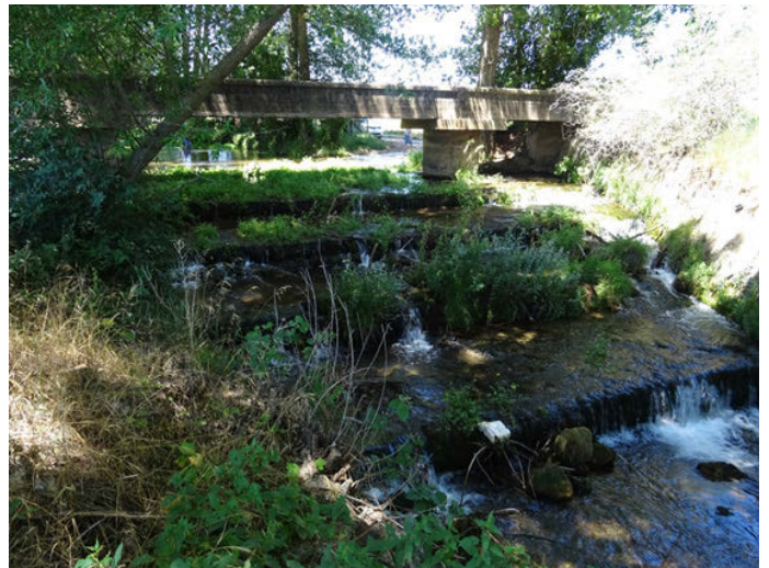
Foto 22. Obstáculo transversal de protección de la infraestructura del puente en "La Veguilla"
