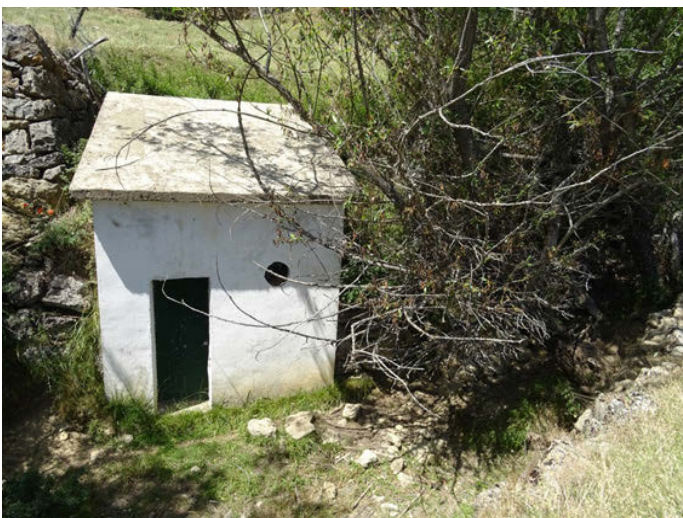
Foto 5. Infraestructura ocupando el DPH en el tramo alto de la RNF del Río Guadalaviar
