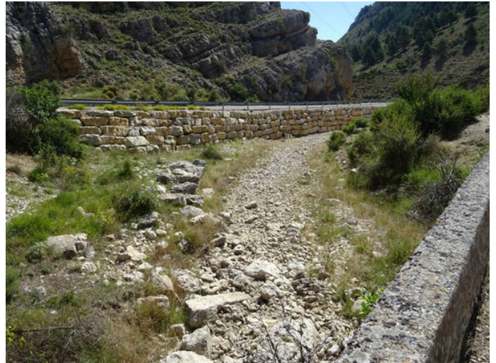
Foto 14. Estructura de estabilización de la carretera TE-V-9033 aguas abajo de Villar del Cobo
