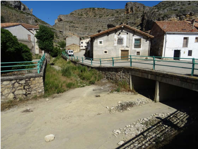
Foto 13. Encauzamiento del curso fluvial a su paso por Villar del Cobo
