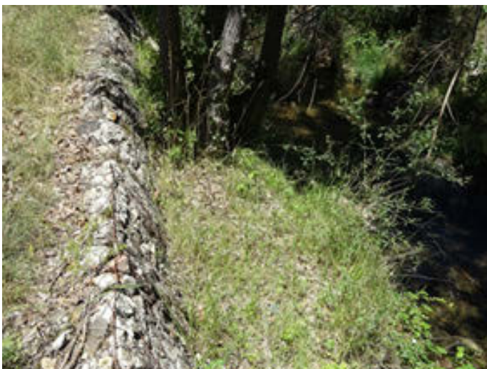
Foto 23. Obras longitudinales de protección de las márgenes del río Guadalaviar
