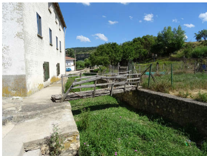
Foto 10. Muros en las márgenes del cauce en el curso fluvial a su paso por Guadalaviar
