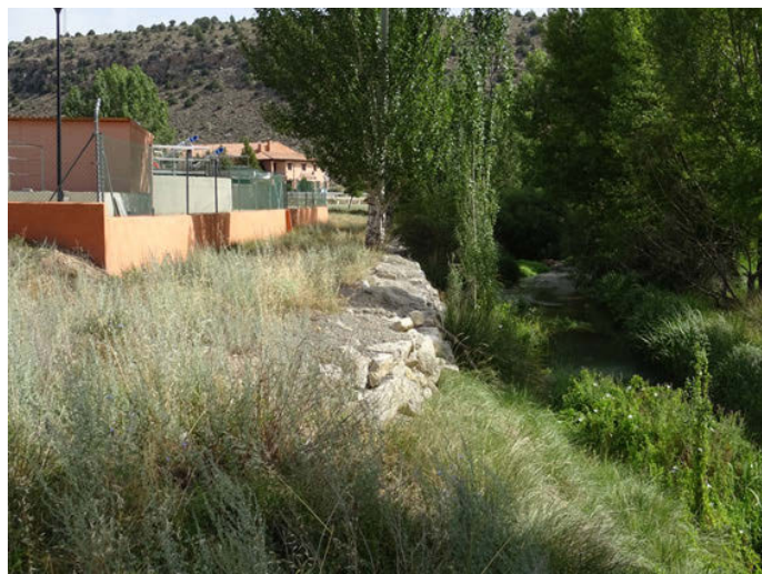
Foto 32. Escollera de protección de la margen izquierda donde se ubica la EDAR de Albarracín
