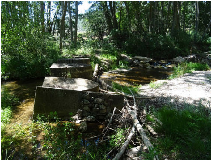
Foto 19. Azud y antiguos pilares de un puente ocupando el DPH de la reserva.
