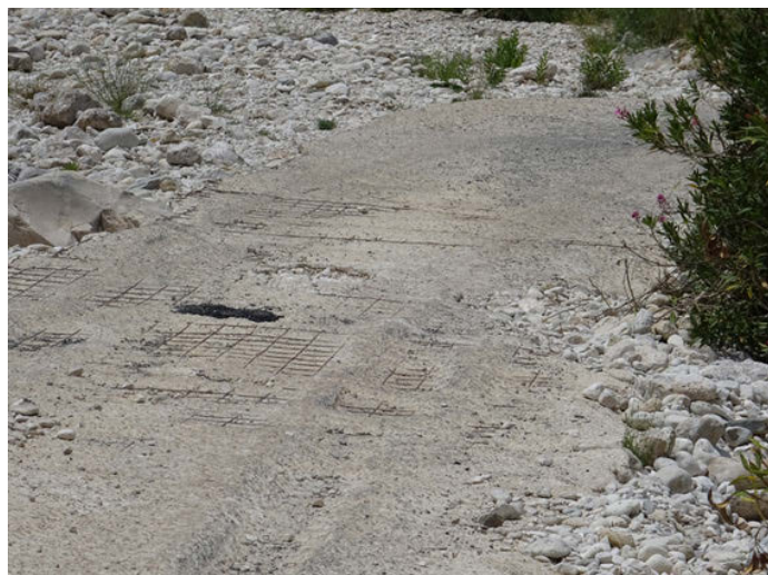
Foto 8. Vado de hormigón en el tramo medio de la RNF del Río Jalón
