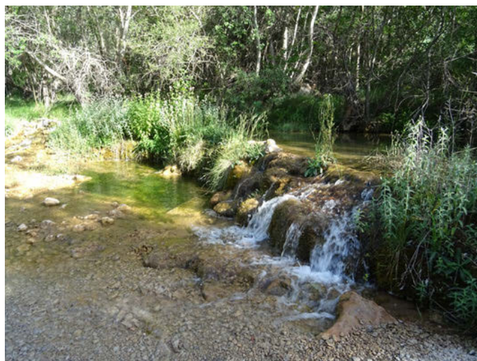
Foto 16. Azud conocido como Encima de la Piscifactoría que se convierte en un obstáculo transversal al cauce que limita la continuidad piscícola.
