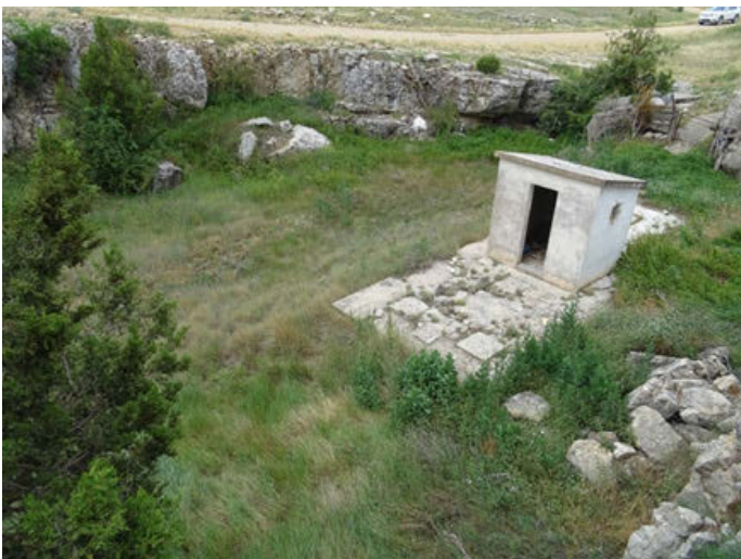
Foto 5. Imagen del tanque almacenamiento abandonado de residuos localizado en el municipio de Valdecuencia.
