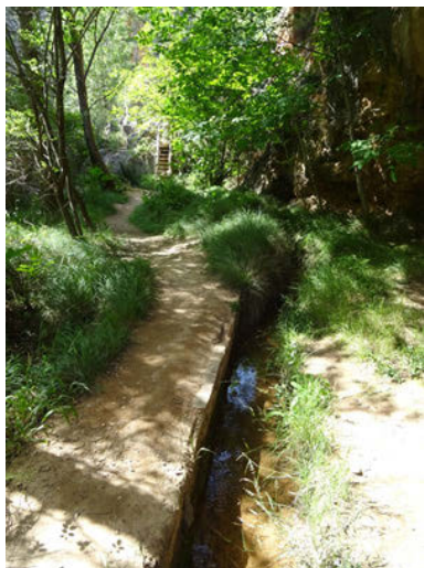
Foto 13. Acequia proveniente del Azud de los Estrechos.
