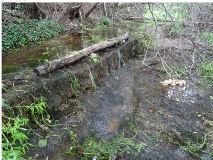
Foto 9. Azud conocido como Presa de Abajo situado en la localidad de Tormón que se convierte en un obstáculo transversal al cauce que limita la continuidad piscícola.
