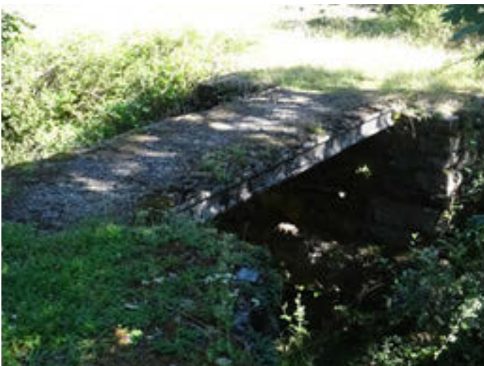
Foto 5. Puente que permite el paso por el sendero a la otra margen del río.
