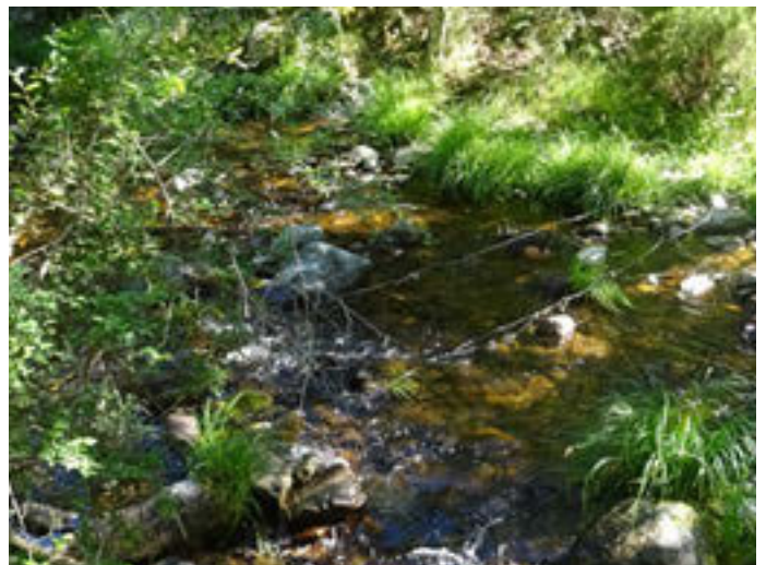
Foto 6. Cercado cruzando el cauce para evitar el paso del ganado.
