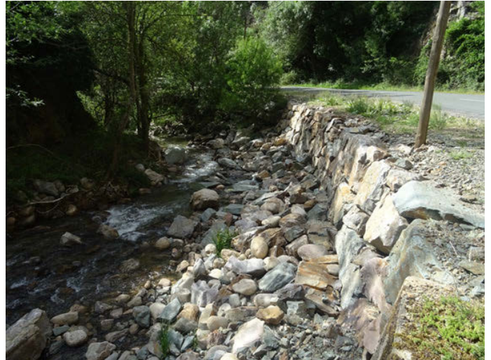
Foto 2. Escollera en la margen derecha del río Urbión (Zona 3).
