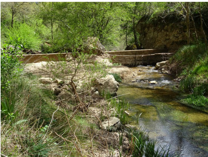
Foto 5. Restos de la infraestructura del azud permeabilizado antes del inicio de las hoces.
