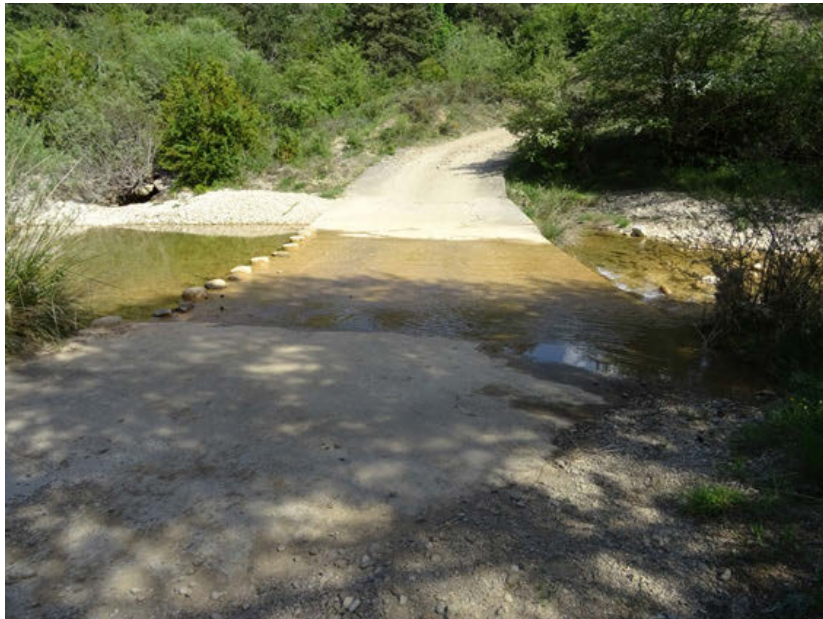
Foto 8: Paso sobre paramento con pequeño salto vertical al final del tramo 1
