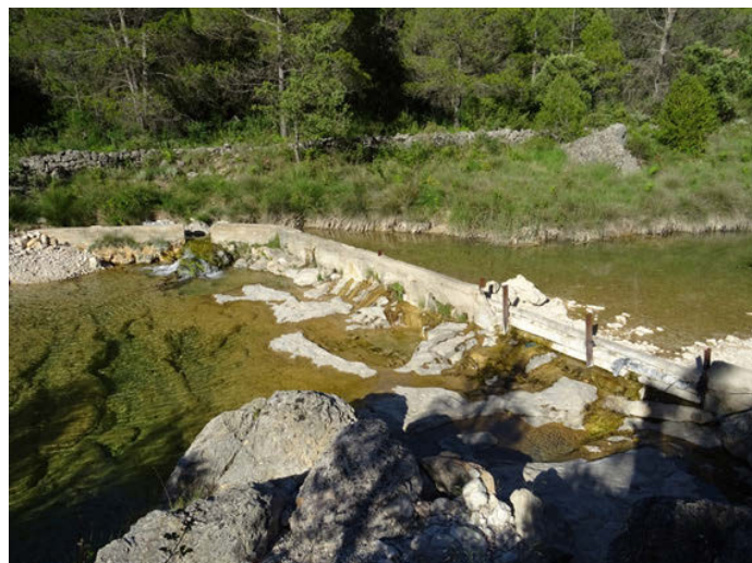
Foto 8. Azud con canal de derivación construido con hormigón y madera.
