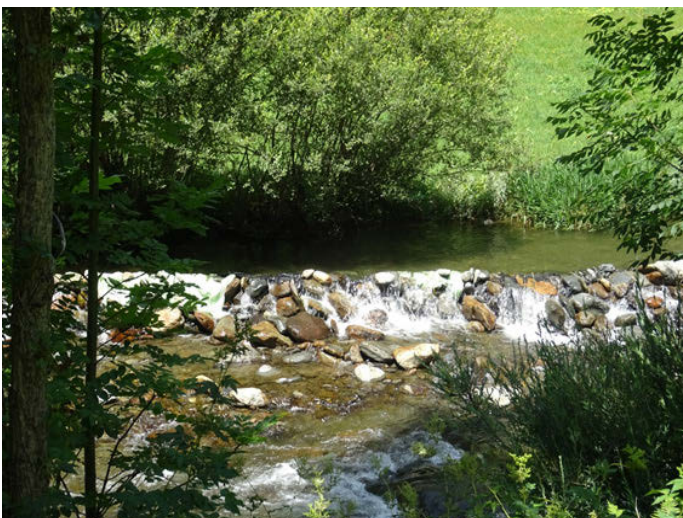
Foto 5. Azud con piedras y plásticos para riego de prados.
