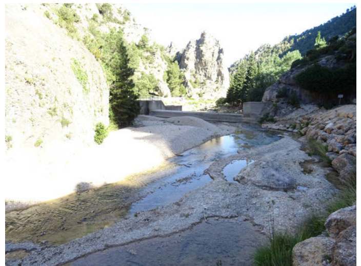
Foto 12. Acumulación de gravas en el azud del Pantano de Pena y escollera en la margen derecha.
