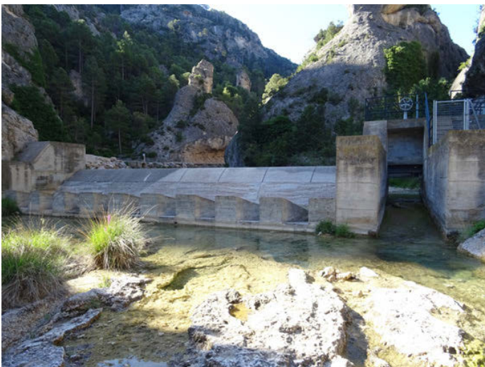
Foto 11. Azud del Pantano de Pena en el tramo bajo de la RNF del Río Matarraña.
