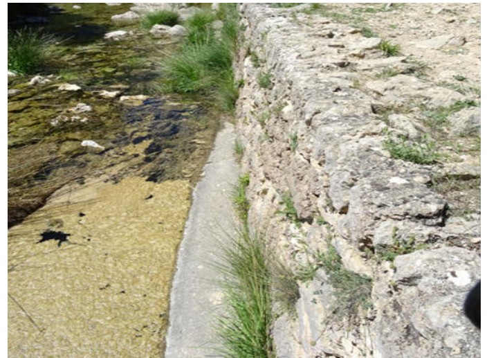
Foto 10. Obra longitudinal en el camino y antigua canalización de agua en desuso.
