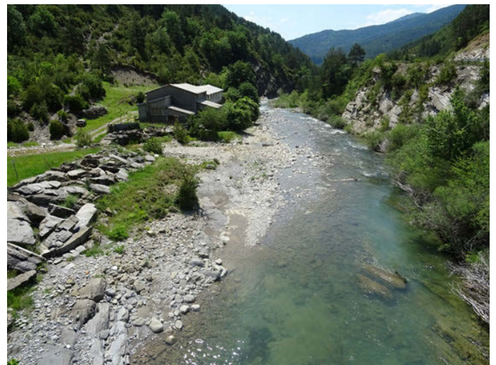
Foto 6. Granja y escollera en la margen izquierda del río Veral.
