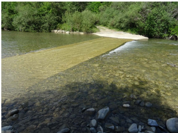
Foto 7. Paso sobre paramento para permitir el paso de vehículos a la otra margen del cauce.
