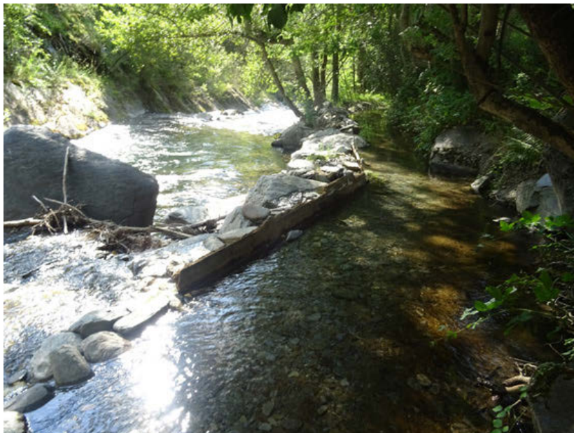
Foto 6: Canal de derivación para riego de prados en el final de la RNF.
