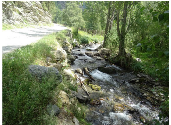
Foto 4: Pista protegida con escollera en DPH, localizada en la zona 2.
