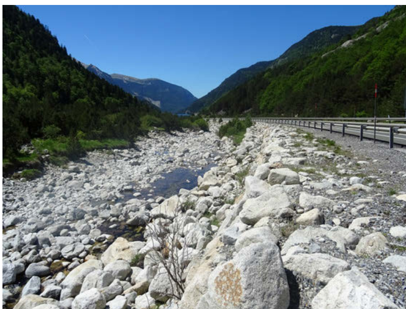
Foto 8. Carretera N-230 y escollera de protección en la margen derecha en tramo 5
