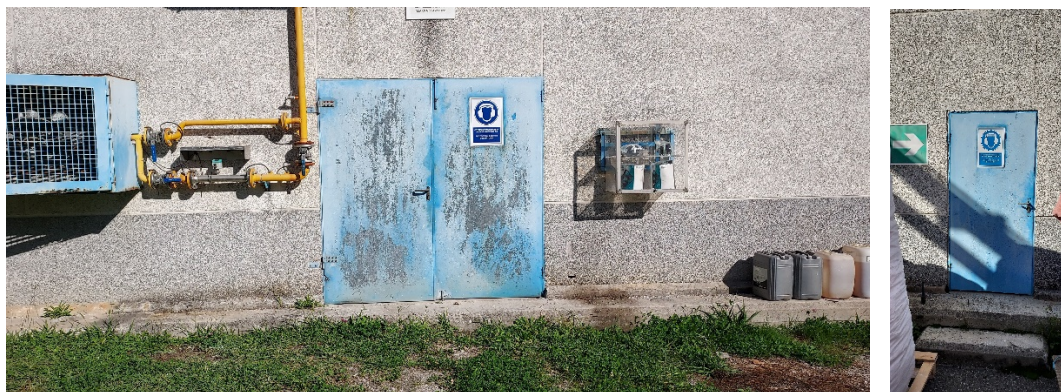
Ilustración 46 Acceso a naves de frío
