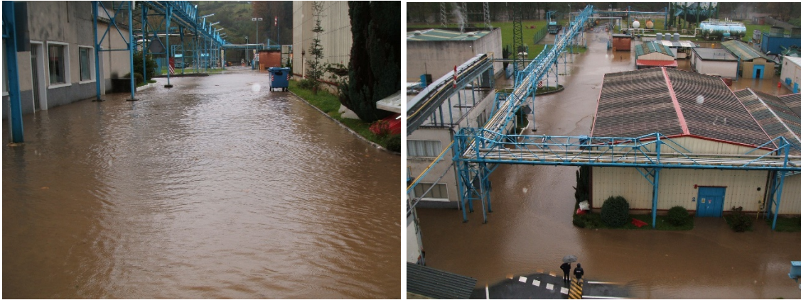
Ilustración 3 y 4: Inundaciones en zona de naves
