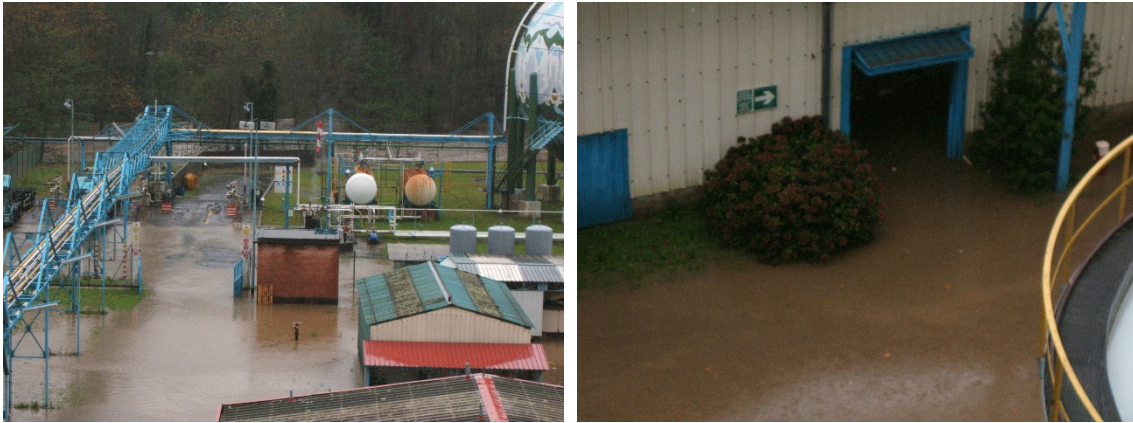
Ilustración 5 y 6: Inundaciones en instalaciones
