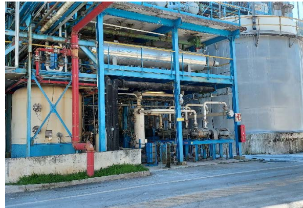
Ilustración 32 Aparcamiento de vehículos afectado
