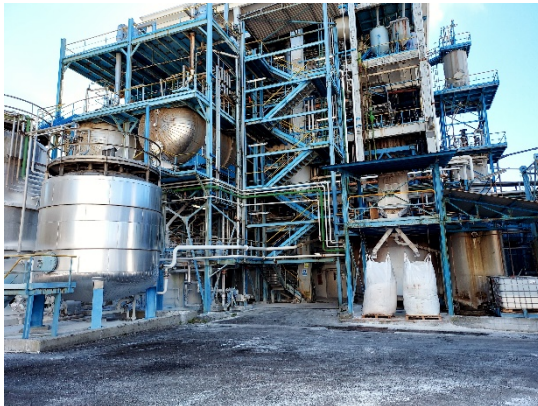
Ilustración 31 zona de sótano afectado
