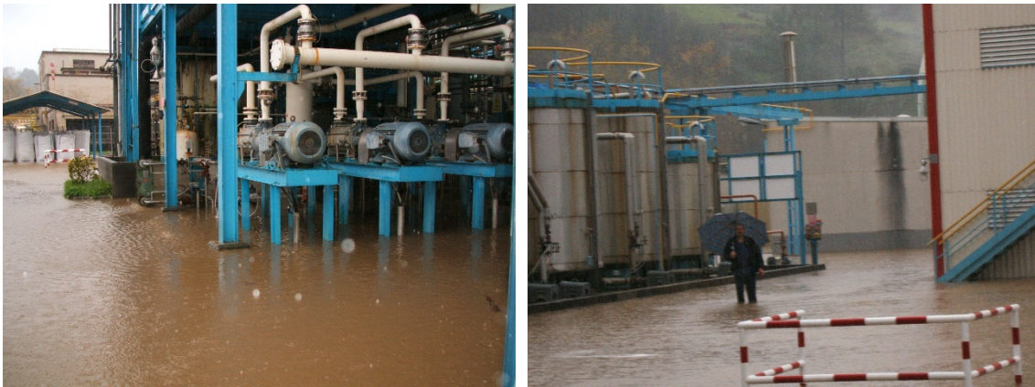
Ilustración 9 y 10: Inundaciones en instalaciones
