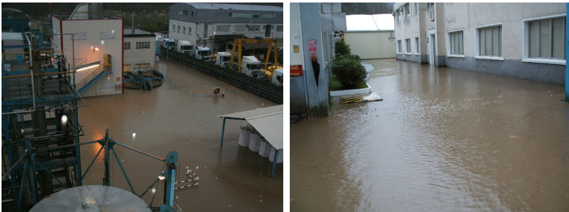
Ilustración 7 y 8: Inundaciones en instalaciones
