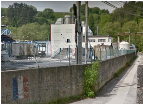
Ilustración 26 Muro divisorio parte norte
