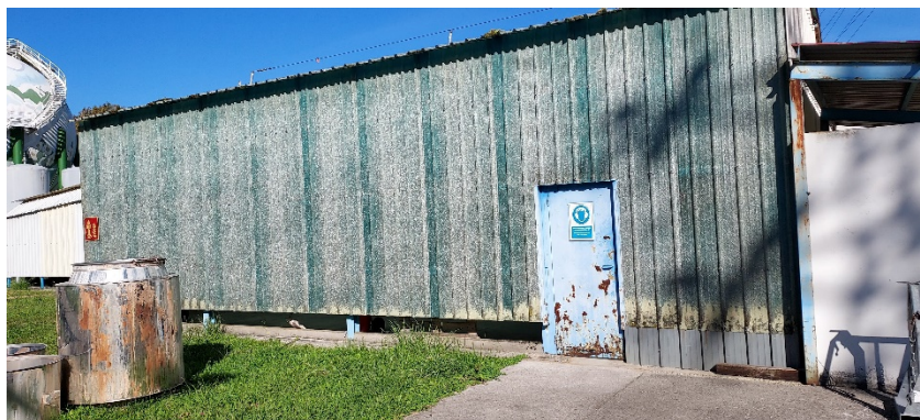
Ilustración 34 sala de grupos electrógenos
