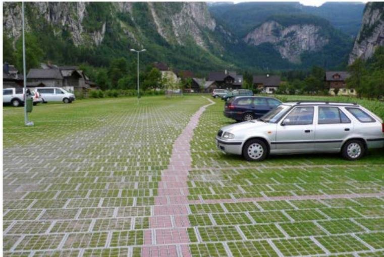
*Ilustración 35. Ejemplo de instalación de pavimento filtrante.*
