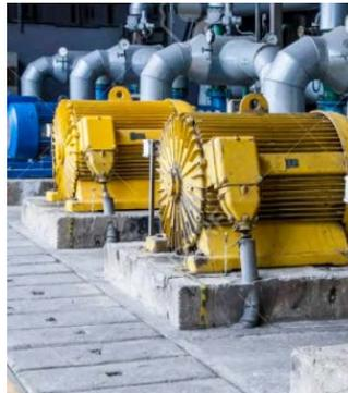
Ilustración 32. Ejemplo de elevación de equipos
