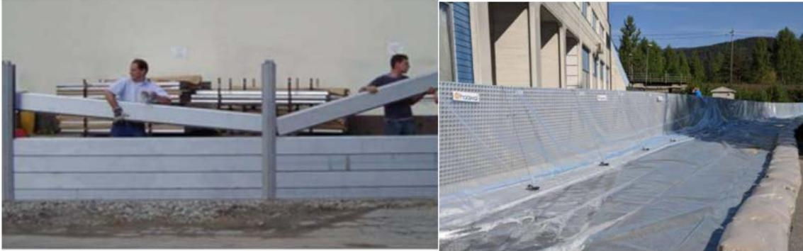
Ilustración 29. Barrera temporal perimetral tipo DPS y tipo Hawaal
