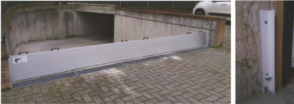
*Ilustración 34. Panel de aluminio instalado y detalle de anclajes.*
