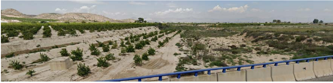
Ilustración 12. Rambla de Abanilla aguas arriba de la A-7.
