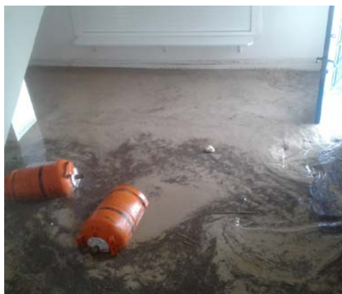
Ilustración 7. Interior de la recepción del edificio de oficinas.
