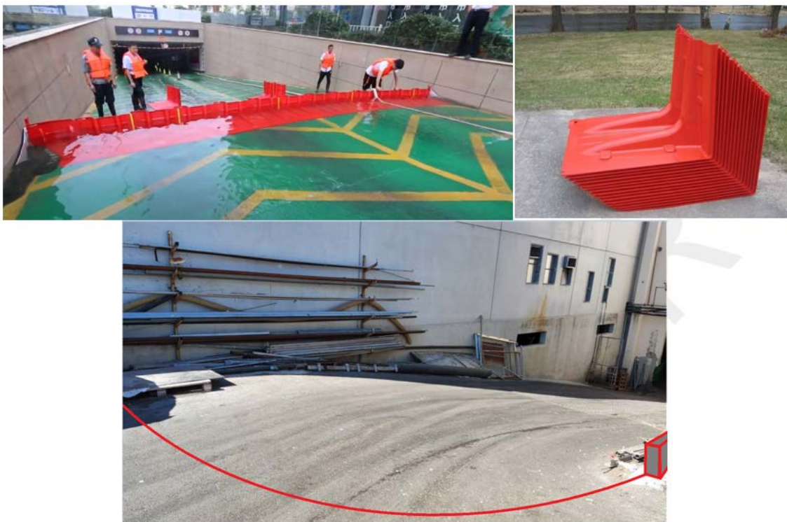
Ilustración 39. Barrera temporal tipo Box Wall y croquis del trazado de la barrera temporal.
