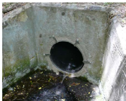
Ilustración 40. Válvula antirretorno e instalación.
