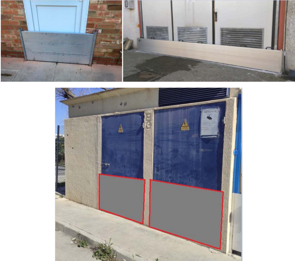
Ilustración 34. Barreras temporales de paneles apilables de aluminio y croquis de ubicación.
