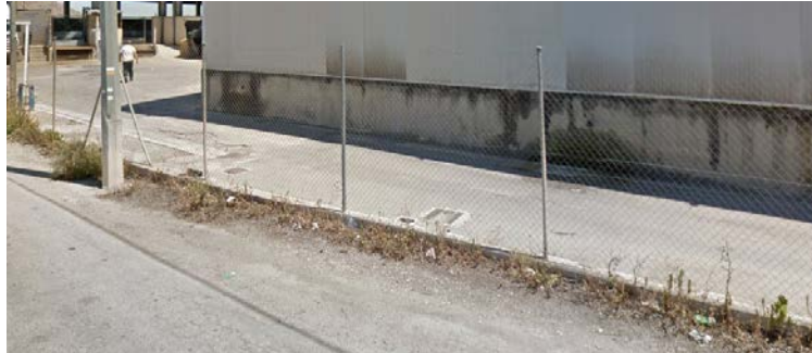
Ilustración 23. Detalle del cerramiento perimetral de la fábrica.
