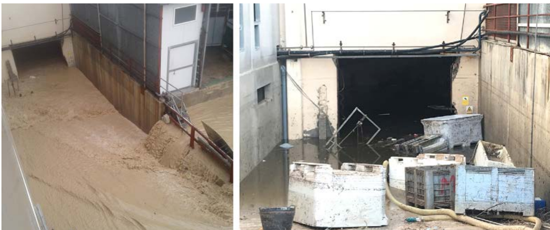
Ilustración 9. Entrada de agua en el sótano durante el episodio (Izq) y achique de agua del sótano tras el episodio (Dcha).
