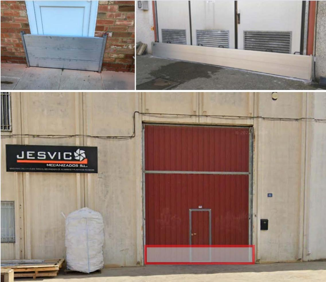
Ilustración 31. Barreras temporales de paneles apilables de aluminio y croquis de ubicación.
