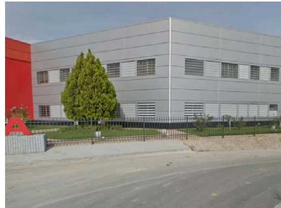
Ilustración 32 Zona este exterior de las instalaciones
