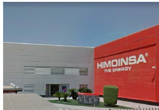
Ilustración 30 Zona sur de las instalaciones
