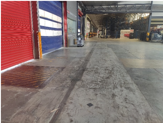
Ilustración 31 Interior de la nave
