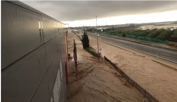
Ilustración 8: Zona de acceso a la fábrica
