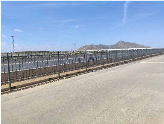
Ilustración 27 Vallado sur existente
