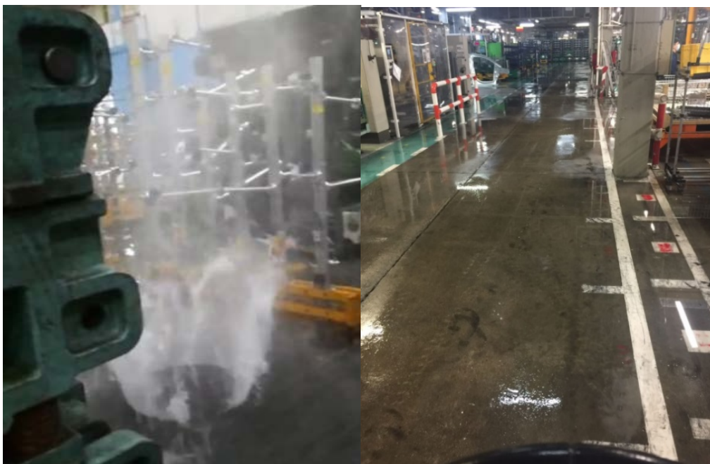
Ilustración 7: entrada en carga de la red de aguas pluviales
