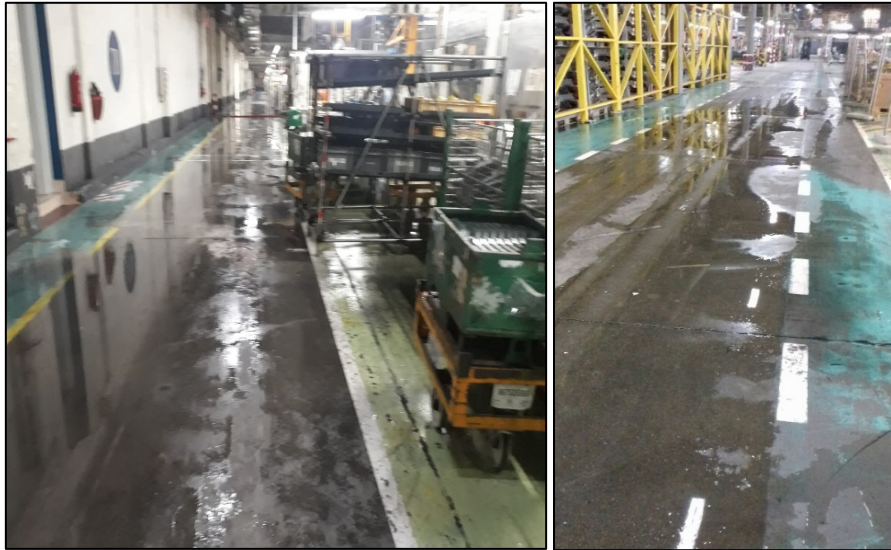
Ilustración 3: Zonas internas de la fábrica
