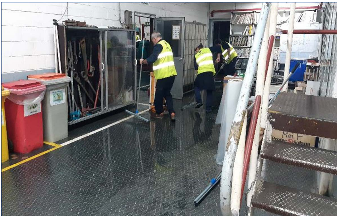
Ilustración 6: nave F, pequeñas inundaciones
