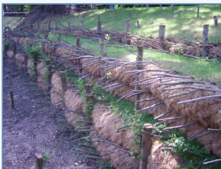
Foto 40. Estaquillados en obras de bioingeniería.
