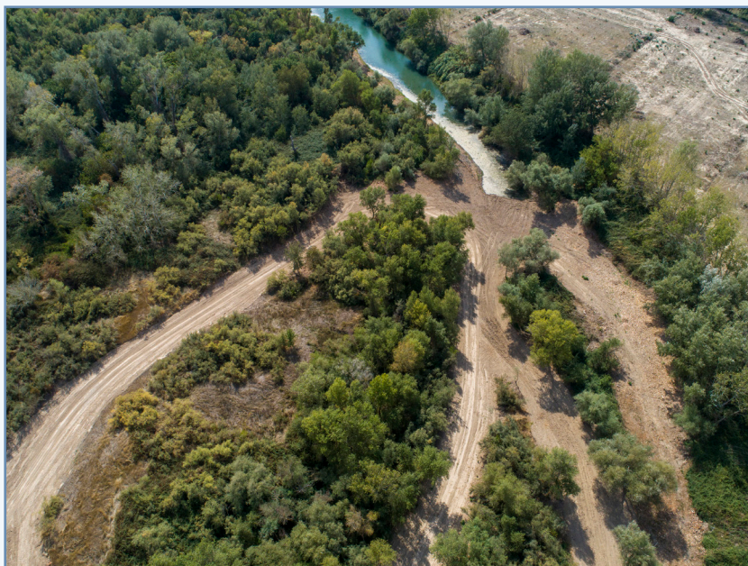
Foto 31. Ejemplo de técnica de "curage": Despeje de la vegetación, apertura de cauces secundarios y labrado de sedimentos en el eje del río Ebro.
