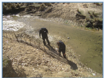
Foto 38. Fase 4: Proceso de la construcción de una empalizada viva de sauce.
