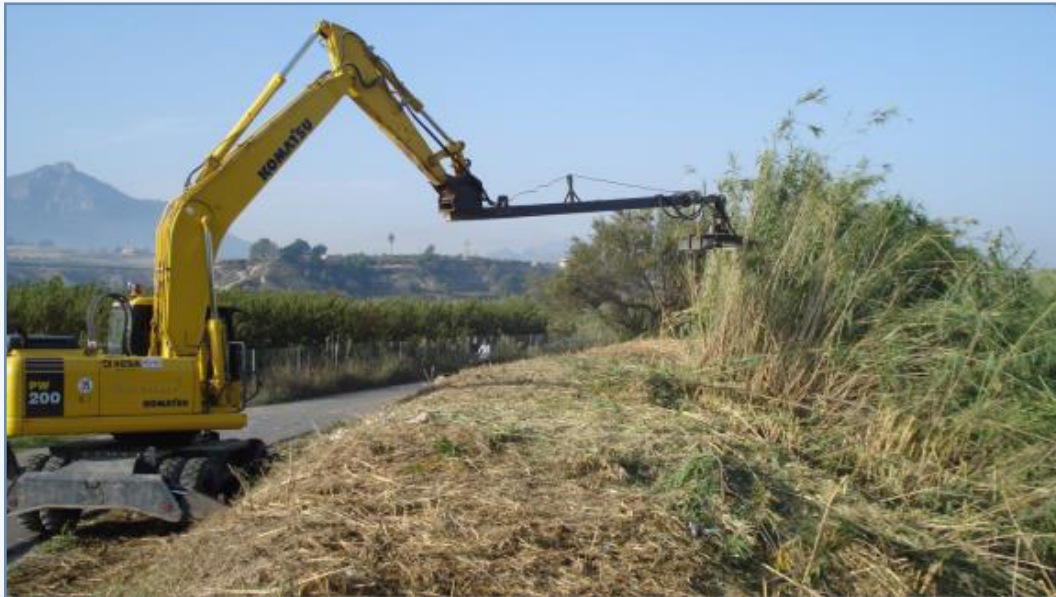
Foto 16. Desbroce de la parte aérea de la caña.
