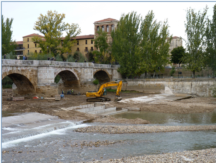
Foto 24. Imagen del proceso de la demolición parcial del azud del puente de San Marcos en el río Bernesga en León.
