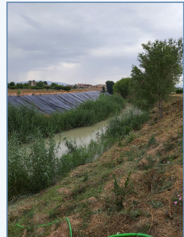
Foto 20. Desbroce de la parte aérea de la caña e instalación de lámina de geotextil para el cubrimiento de la superficie desbrozada en Molina de Segura (Murcia).
