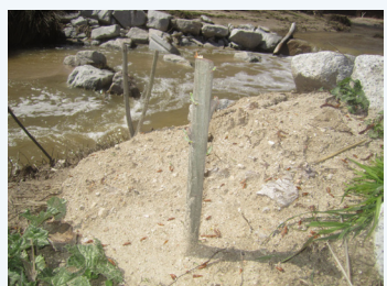
Foto 39. Estaquillado de sauce: estaquillado simple y en empalizada viva.
