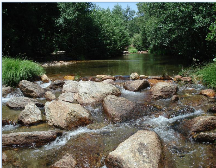
Foto 21. Rampa para el paso de peces en el río Negro (Zamora) ejecutada por la Confederación Hidrográfica del Duero.
