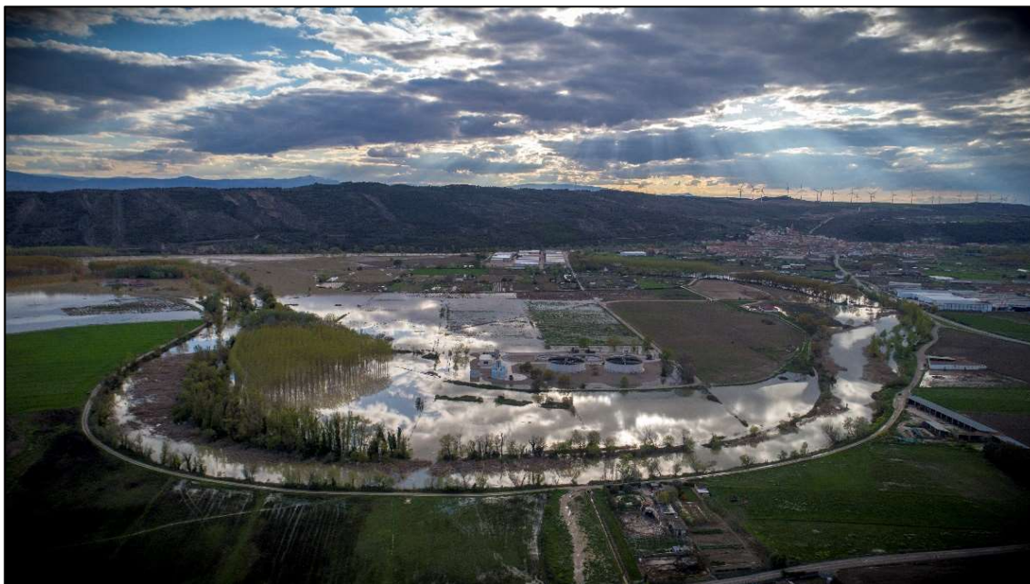
Figura 6. Meandro inundado del río Arga en Funes (Navarra) el 12 de abril de 2018. Fuente: Confederación Hidrográfica del Ebro.
