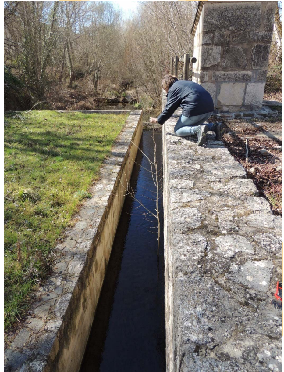
Estación de aforos ACA 41 (Río Ciurana aguas debajo de la derivación del Traspase a Ruidecañas (21/2/2018)
