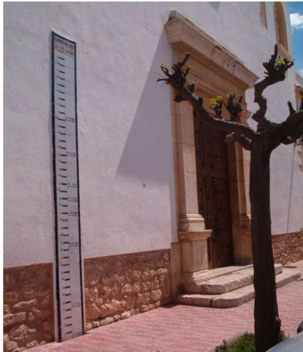
Figura 53. Escala limnimétrica de la fachada de la iglesia de Sant Martí en Xerta. Reúne las cotas máximas del agua de las inundaciones del río Ebro entre 1.617 y 1.961. El límite superior alcanza los 10 m de calado sobre el fondo del cauce del Ebro (Fuente: Balasch, 2021).
