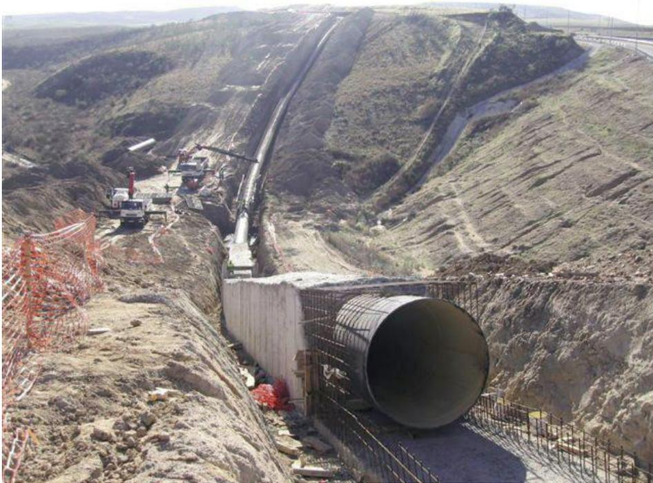
**Ilustración 1: Conducción del segundo anillo de agua potable del área metropolitana de Madrid.**
