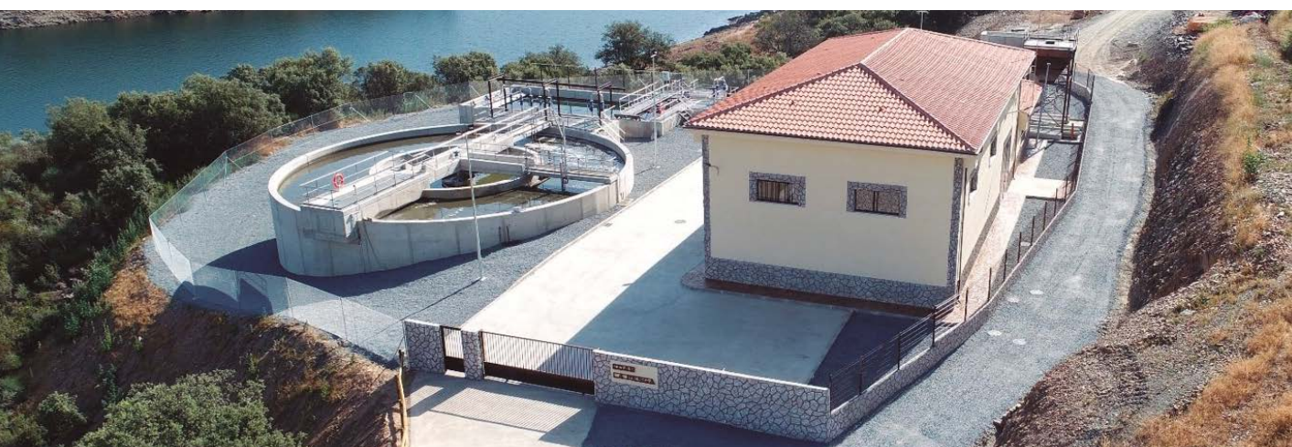
La Pesga WWTP, Tajo basin (Cáceres, Extremadura)
