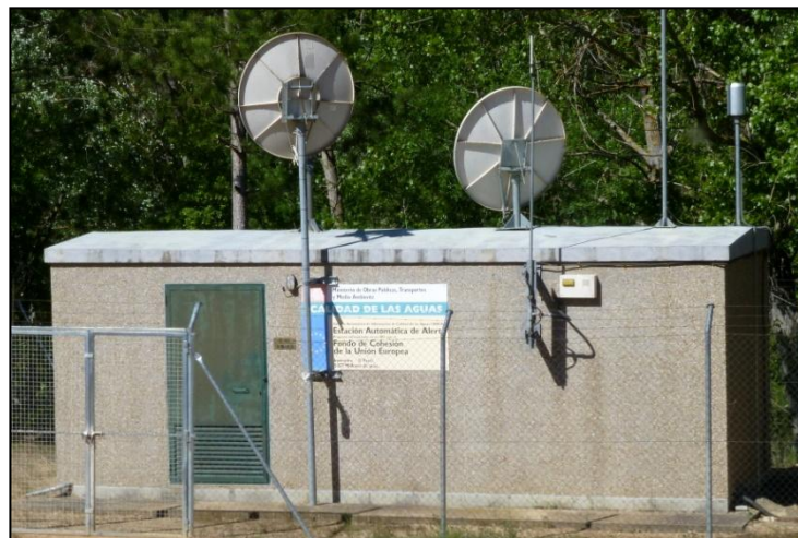
Ilustración 1: Estación automática de medida de la calidad del agua (Red SAICA) en Trillo (Guadalajara). Demarcación Hidrográfica del Tajo.
