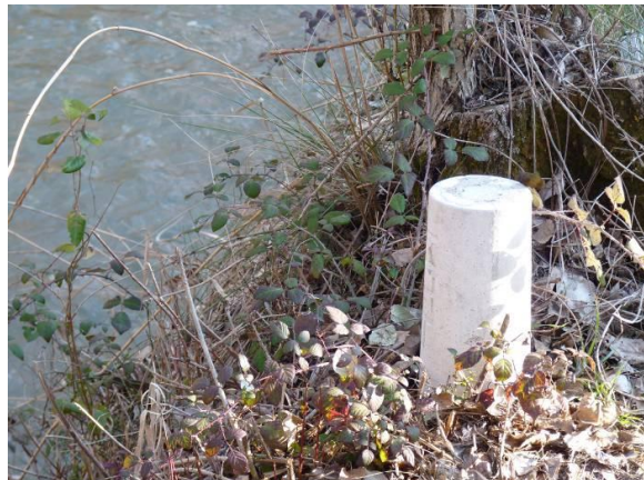
Ilustración 2: Mojón para la delimitación del dominio público hidráulico en el río Henares (Confederación Hidrográfica del Tajo).
