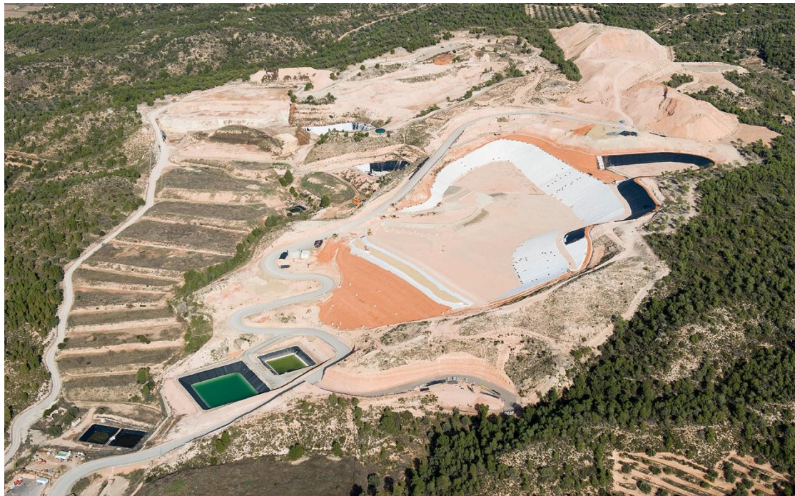
Ilustración 5: Depósito controlado de residuos.
