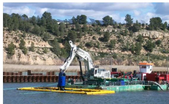
Ilustración 2: Proceso de dragado ecológico.
