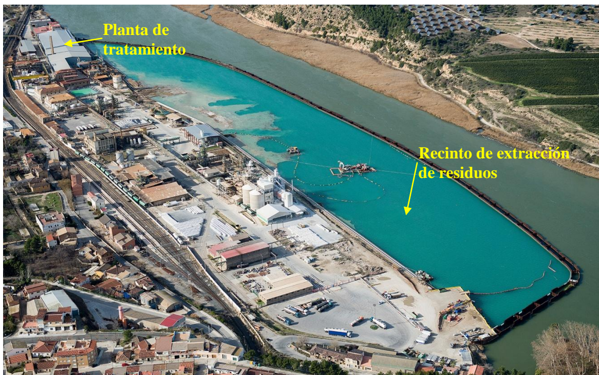
Ilustración 1: Recinto cerrado en el río Ebro donde están situados los residuos a dragar. Pueden apreciarse también los edificios de la planta de tratamiento.
