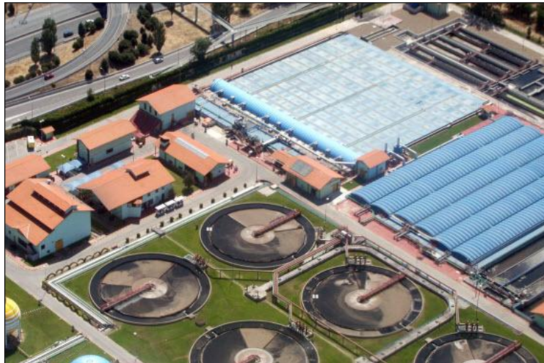
Ilustración 2: Planta regeneradora de agua dentro de una EDAR en Madrid con una producción de agua para riego de parques y zonas verdes y con una gestión financiera basada en la recuperación de costes.
