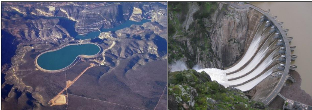
Ilustración 1: A la izquierda, el complejo de Cortes la Muela (cuenca del Júcar) que tiene instalados 2.000 MW de potencia, siendo el mayor complejo hidroeléctrico de bombeo de Europa. Utiliza excedentes energéticos cuando sobran en el sistema y los aplica para producir energía cuando existe demanda punta. A la derecha, la presa de Aldeadávila (cuenca del Duero) construida en 1962, con una altura de 140 metros y una potencia instalada de más de 1.100 MW.
