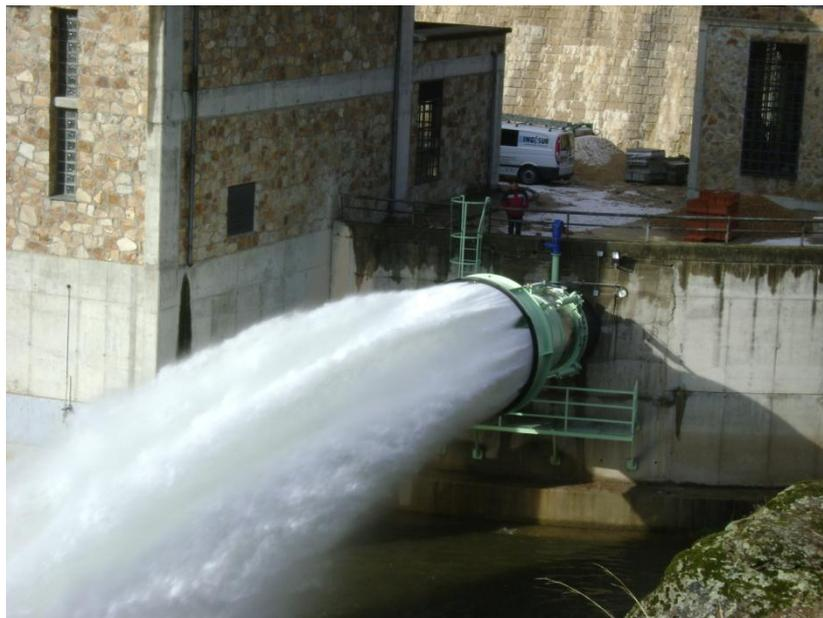
**Ilustración 2: Desagüe de fondo de una presa.**
