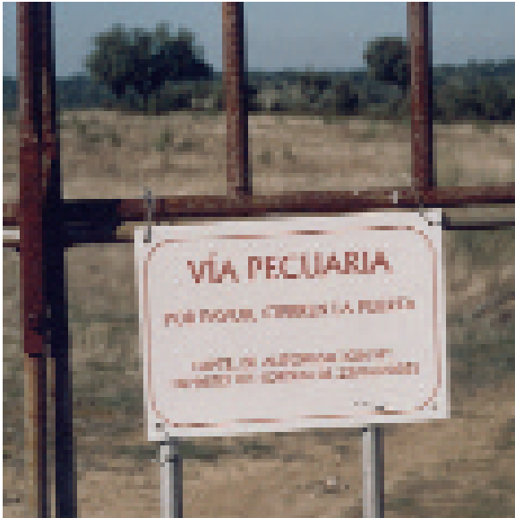
“Foto 5”: Portera practicable en la Cordel de Alcántara en Salorino (Cáceres). La anchura será proporcional al ancho de la vía pecuaria. Si la vía pecuaria soporta un camino, deberá tener un paso canadiense adosado a la portera.
