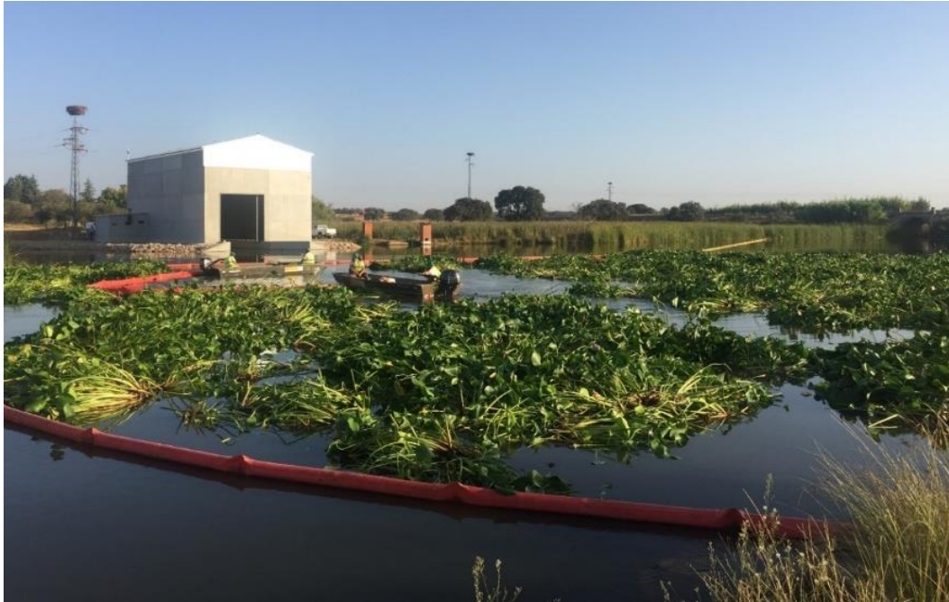
Figura 9. Retención del camalote en el río Guadiana mediante barreras flotantes. Autora: Mihaela Pirvu.
