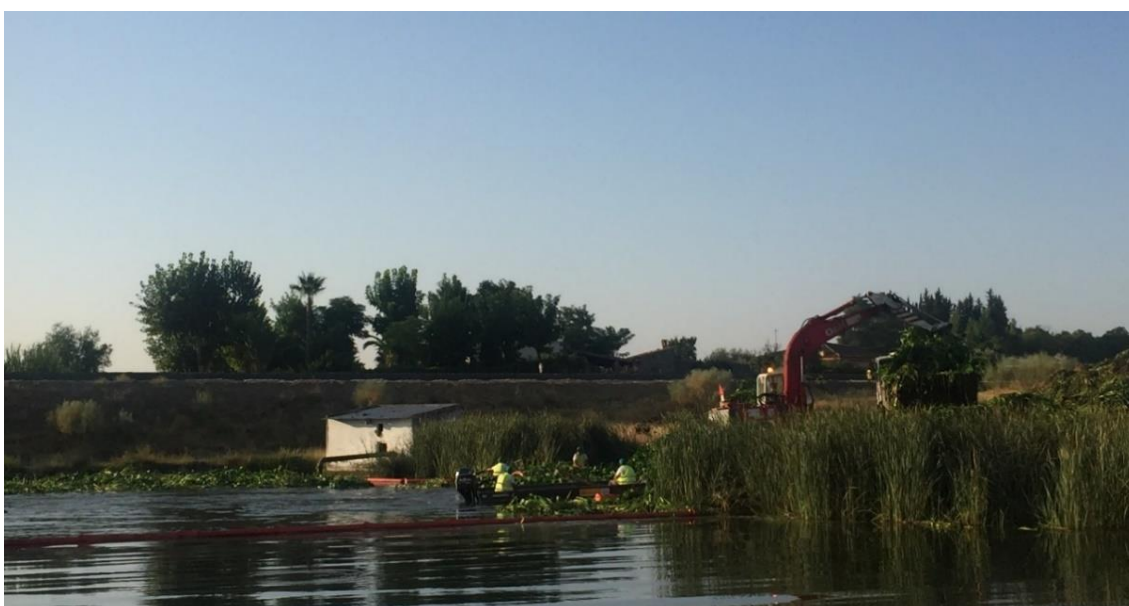
Figura 7. Extracción del camalote del Guadiana con retroexcavadoras y con el trabajo conjunto de barcas y barreras. Autora: Mihaela Pirvu
